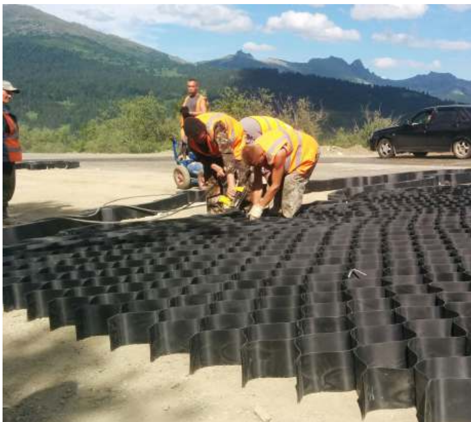
Капитальный ремонт автомобильной дороги Р-257 «Енисей»
