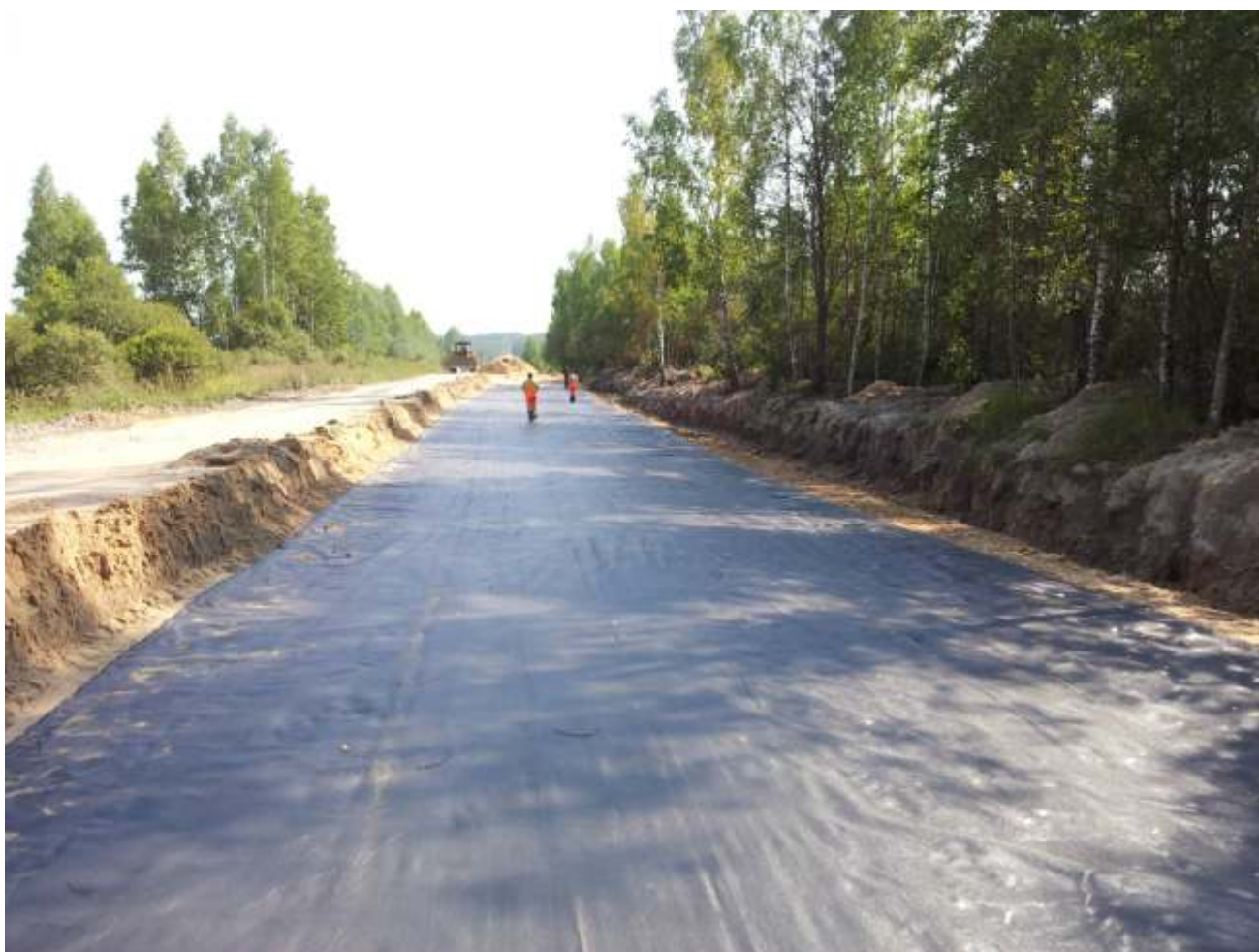
Реконструкция автомобильной дороги «Козельск – Кудринская» в Калужской области
