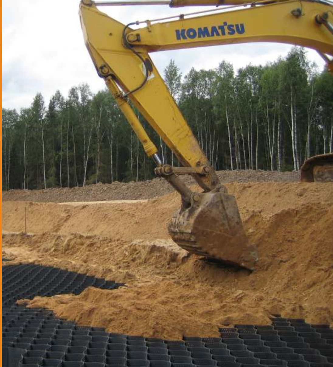
Возведение армирующей геоплатформы (июнь 2014 г.)
