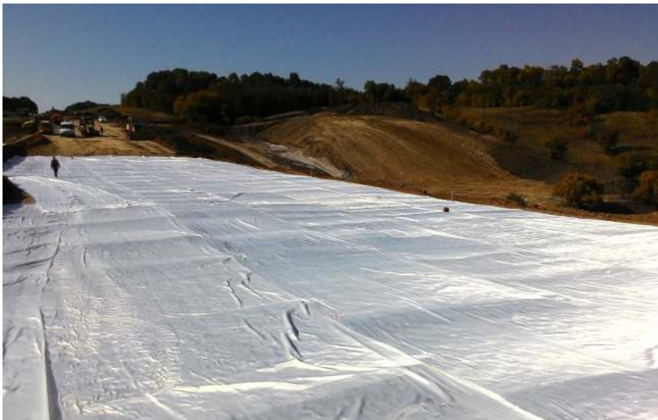
Устройство армогрунтовой обоймы из тканого геотекстиля
